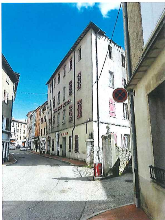
La façade de l'hôtel BEAU SEJOUR côté rue des Cévennes
