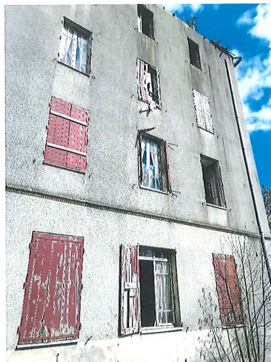
La façade côté immeuble Grosjean
