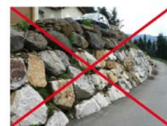
Exemple d'enrochements de type cyclopéen
