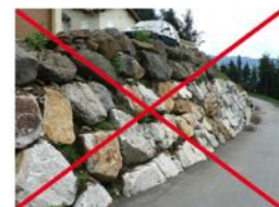
Exemple d'enrochements de type cyclopéen
