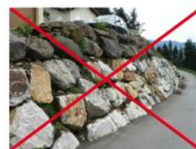
Exemple d'enrochements de type cyclopéen
