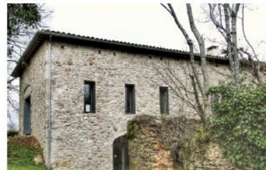
Exemples de traitement de nouvelles ouvertures dans les granges
