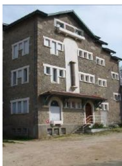
Copropriété privée de 7 logements
