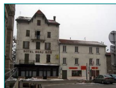
Ancien hôtel Beau Site (travaux d'aménagement d'appartements en cours + une galerie artisanale qui a été créée à droite)
