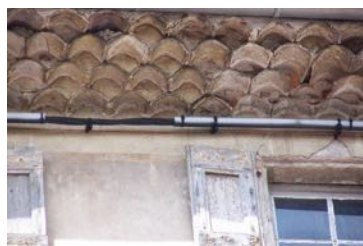
Génoises maçonnées à 4 rangs
