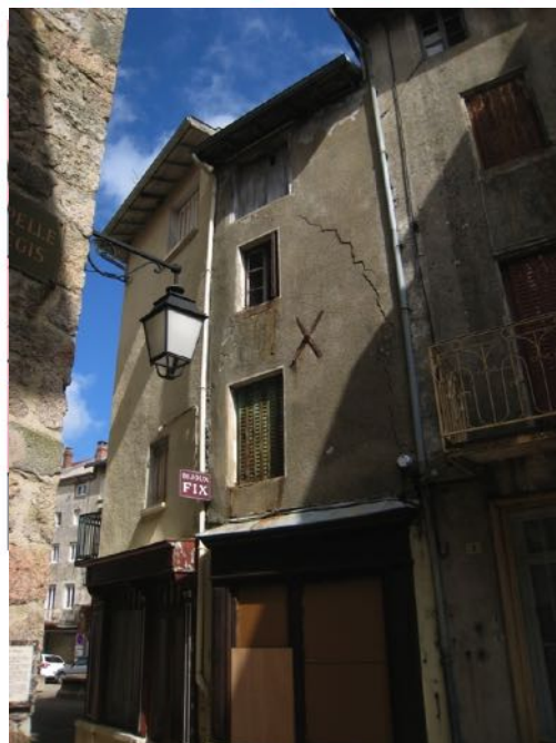
Bâtiments dégradés des parcelles 288 et 289
