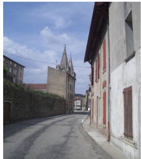
Immeuble rue des Alpes restant à démolir au Sud de la basilique afin de dégager pleinement la perspective sur l'édifice
