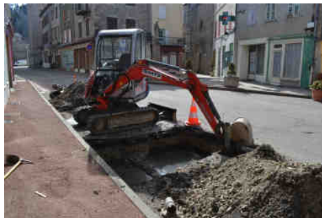
Les premiers dégâts dans le centre
