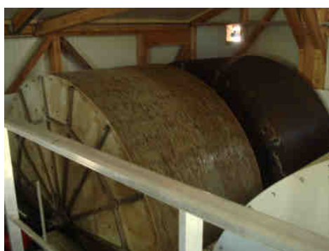
La première batterie de bio-disques entrée en service au début de l'Eté
