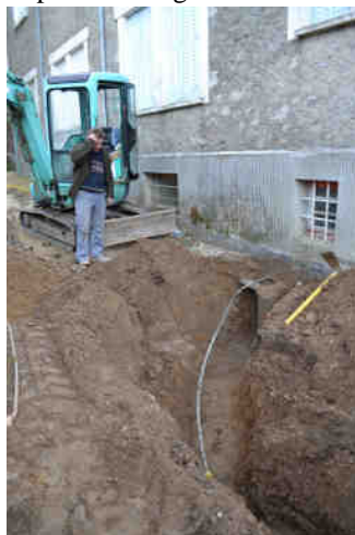
... pour remplacer des tuyaux vétustes et enterrés à trop faible profondeur
