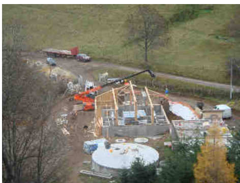
Mise en place de la charpente
