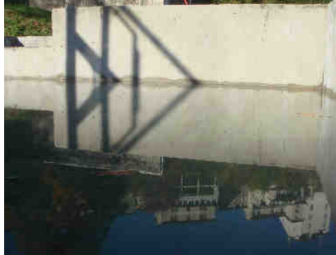
Test d'étanchéité des bassins
