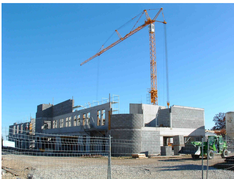
La construction de la nouvelle maison de retraite publique dont l'ouverture est prévue le 1 er avril 2009
